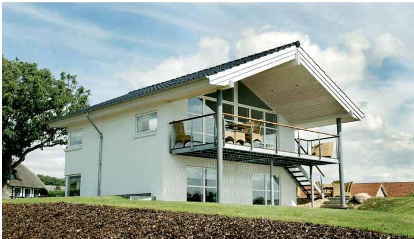
Наиболее экономичными с точки зрения стоимости строительства являются крыши с малым углом скатов. Крыши с углом скатов более 30° являются наиболее привлекательными с точки зрения обустройства подкровельного пространства в жилое помещение, увеличения полезной площади здания и уменьшения стоимости квадратного метра.
