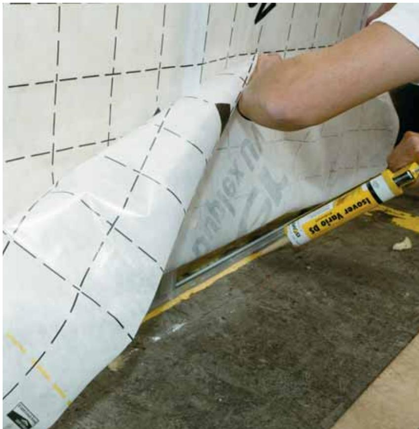
Места примыкания пароизоляционной мембраны к полам и фронтонам обязательно должны быть проклеены специально предназначенным для этого герметиком.
